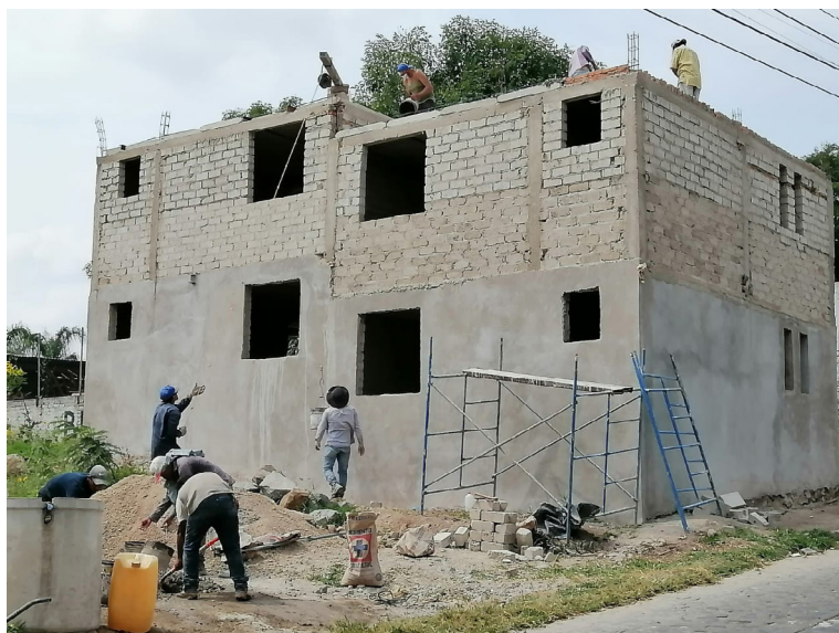
Imagen 42. Construcción de Las Casitas
