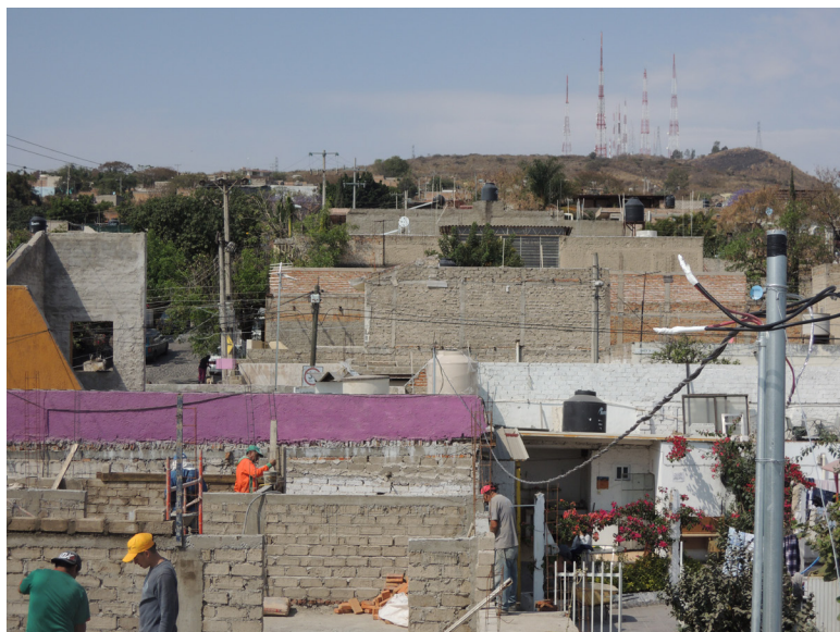
Imagen 13. Obras de ampliación del albergue, al fondo el Cerro del Cuatro
